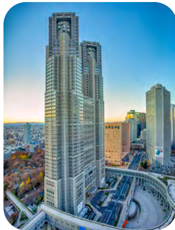
The Tokyo metropolitan government office 東京都庁
